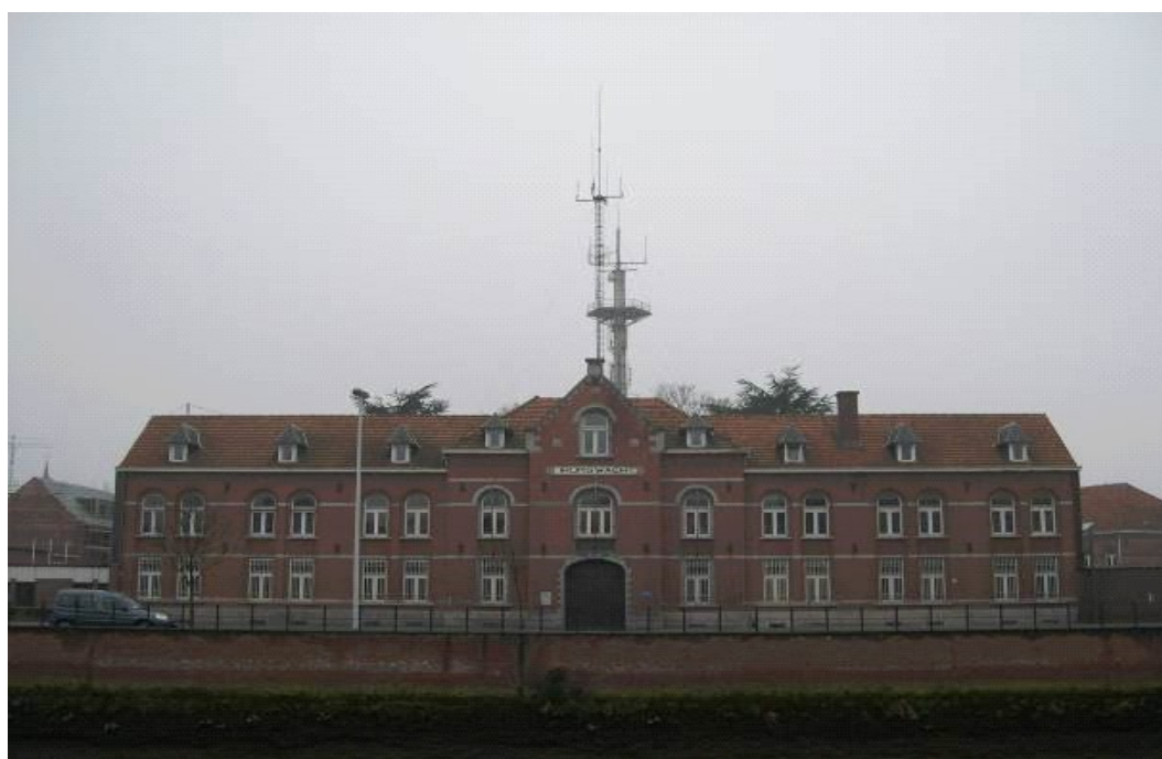
Fig. 19: Noordelijke gevel blok A, huidige situatie (Eeman et al. 2008, 4)
