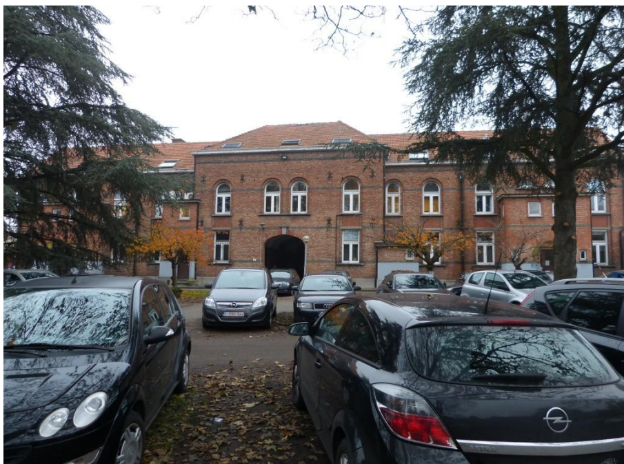
Fig. 20: Achtergevel blok A
