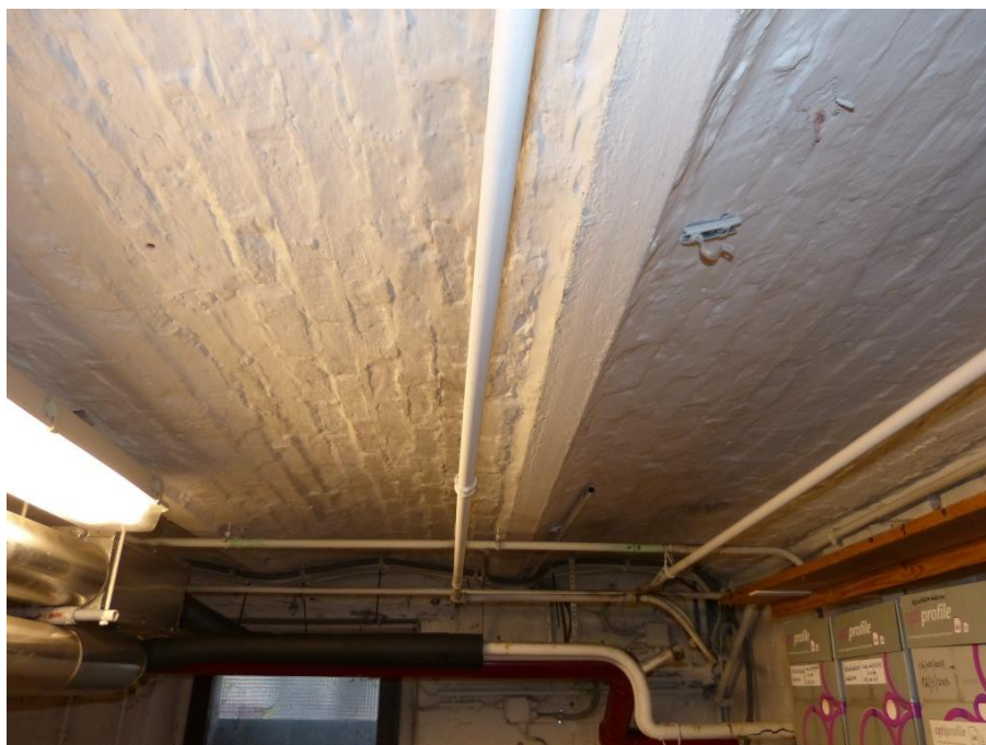
Fig. 32: Troggewelven in de kelder van blok A
