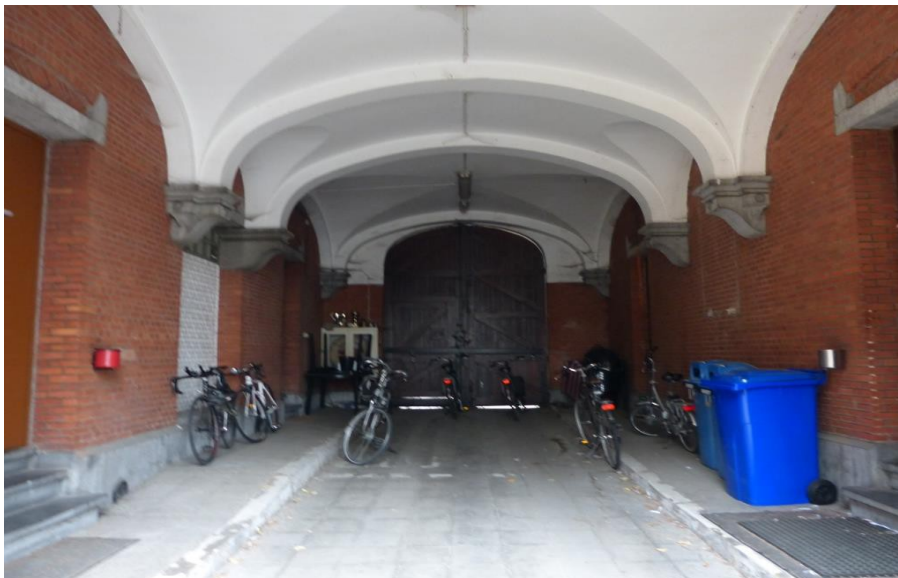
Fig. 24: Zicht op de overwelfde ruimte ter hoogte van de poort in blok A
