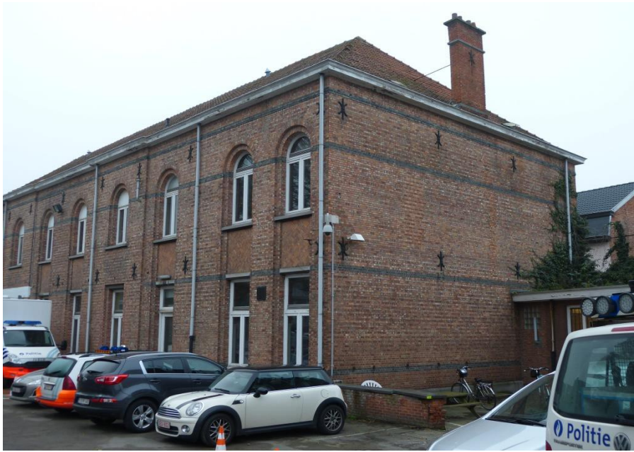
Fig. 28: Zijgevel blok B
