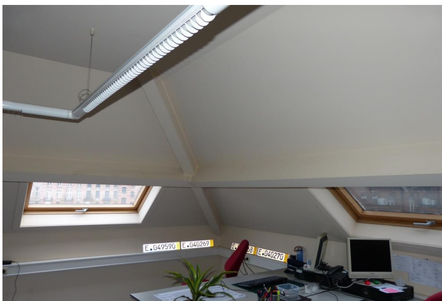
Fig. 43: Zicht op elementen van de dakconstructie van blok C
