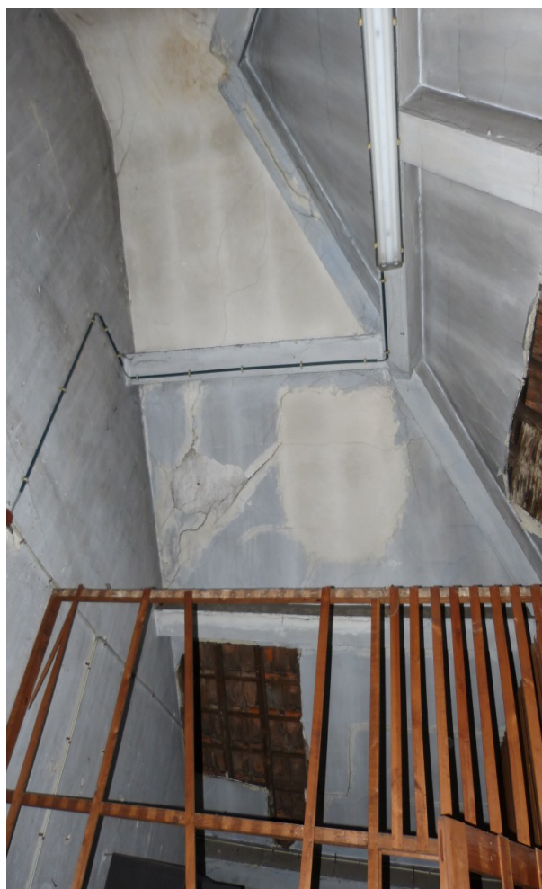
Fig. 41: Zicht op elementen van de dakconstructie van blok B
