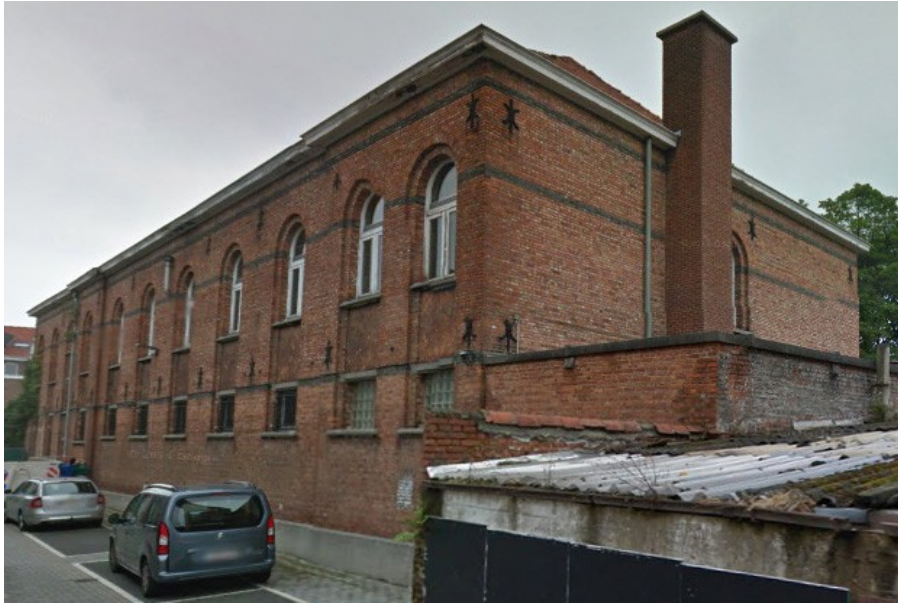
Fig. 29: Achtergevel en zijgevel blok B
