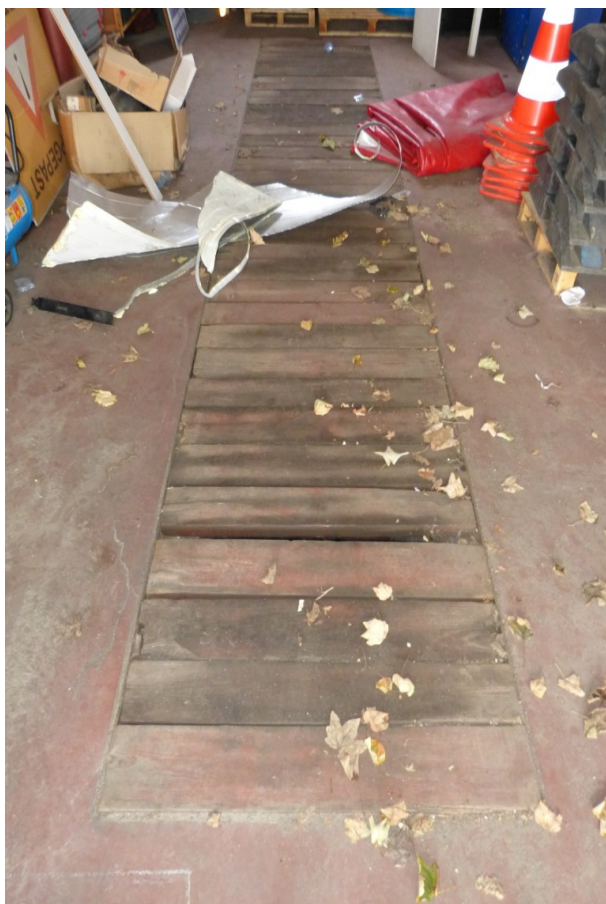
Fig. 37: Dicht gemaakte opening in de vloer van blok B
