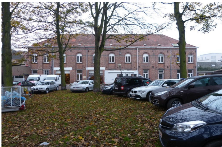
Fig. 27: Voorgevel blok B
