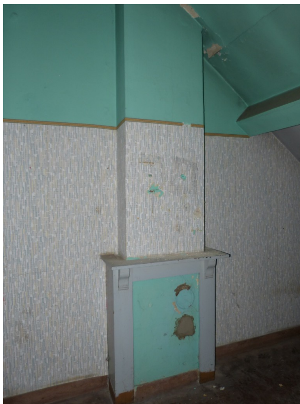
Fig. 38: Haard op de zolderverdieping van blok B
