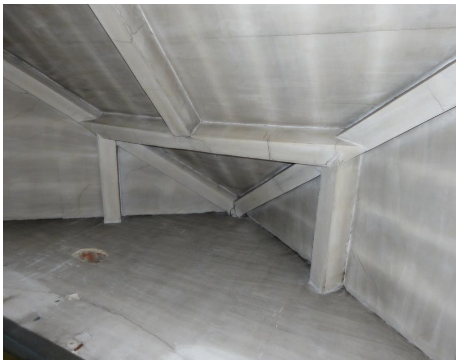
Fig. 40: Zicht op elementen van de dakconstructie van blok B
